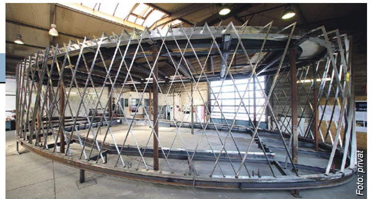
21 Tonnen Stahl und Edelstahl haben die Schneiders für die „Archäologische Vitrine“ zunächst vormontiert ...
