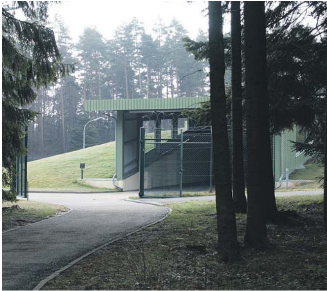
Eingangsbereich in einen ehemaligen Atomschutzbunker, der heute als geschützter Datenspeicher betrieben wird. Wie IT-Sicherheit auch einfacher umzusetzen ist, erklärt ein Vortrag um 21.30 Uhr.
