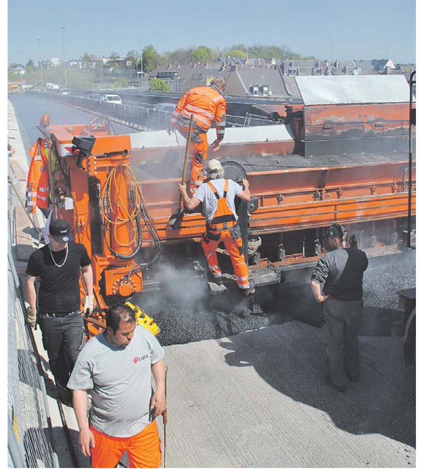
Asphaltierungsarbeiten links, laufender Verkehr rechts.
