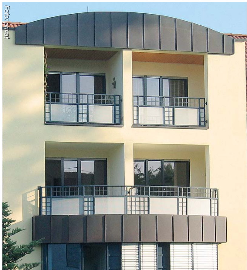
Helle, freundliche Farben werten moderne Fassaden auf. Der Fachbetrieb sorgt dafür, dass alles passt.
