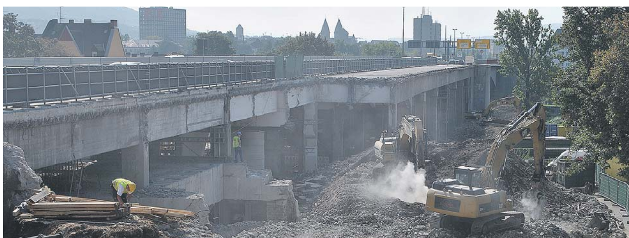
2014 begannen die Arbeiten an der Vorlandbrücke mit ihrem Abriss.
